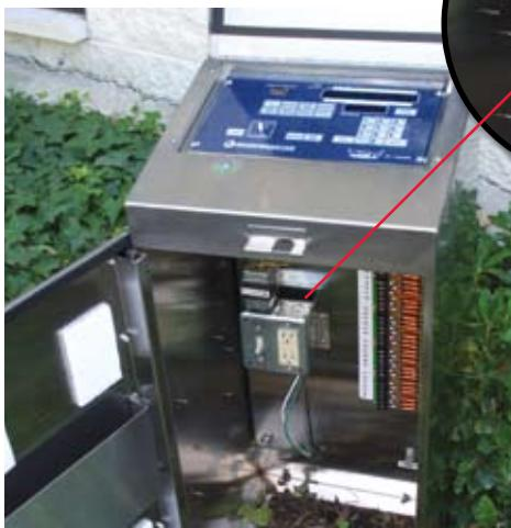
Circuito de falla de tierra con función de apagado de seguridad
