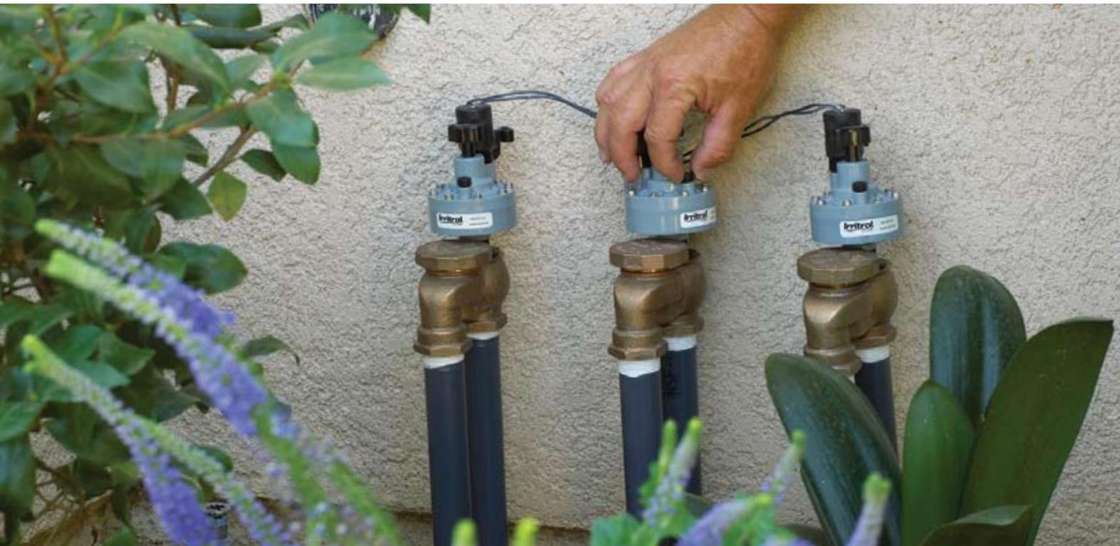
Estos adaptadores de válvulas antisifónicas eléctricas ofrecen una extraordinaria durabilidad y un rendimiento uniforme y confiable en todo tipo de aplicaciones. Además, al tener todos los componentes internos en una misma unidad, la conversión de las válvulas manuales en eléctricas es sumamente sencilla.
